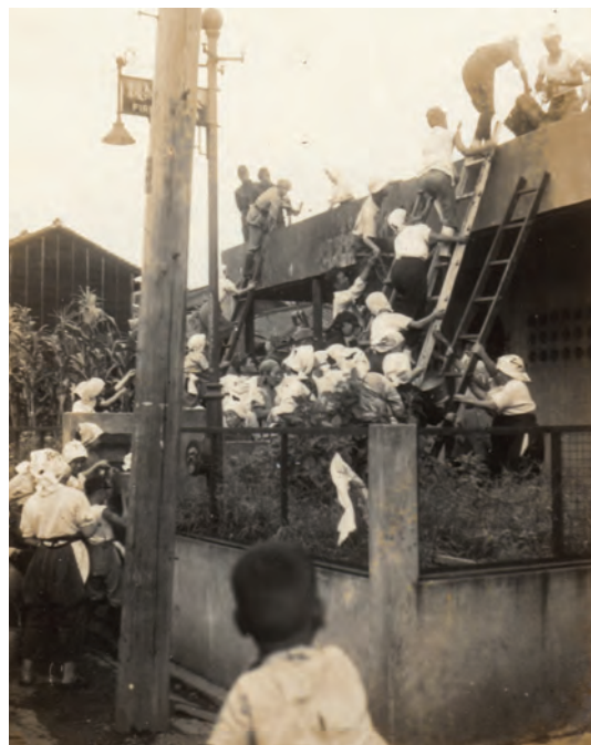
②コンクリート造の建物はプールのシャワー室。手前に訓練の様子を見る子供が写る。
