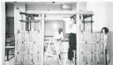
「植木屋の庭」再現工事
