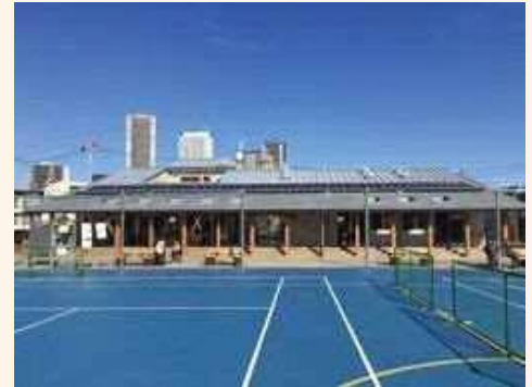
雑司が谷公園丘の上テラスの太陽光パネル
