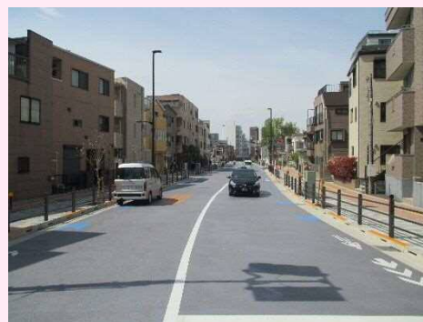
みたけ通りの遮熱性塗装
