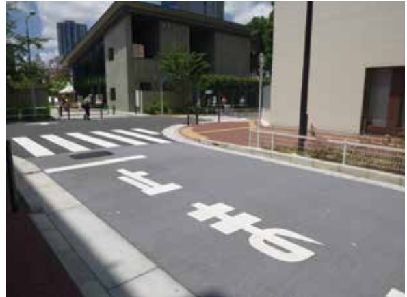
南池袋公園前の遮熱塗装
