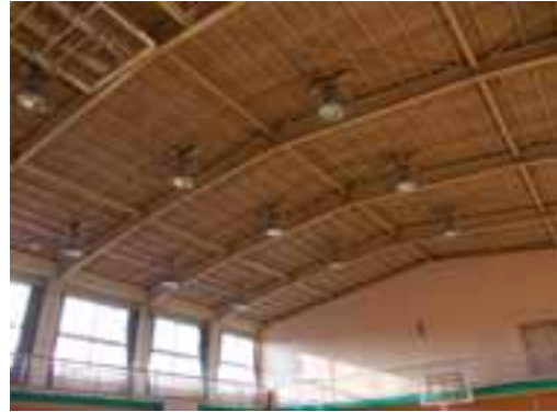
巣鴨小学校体育館
