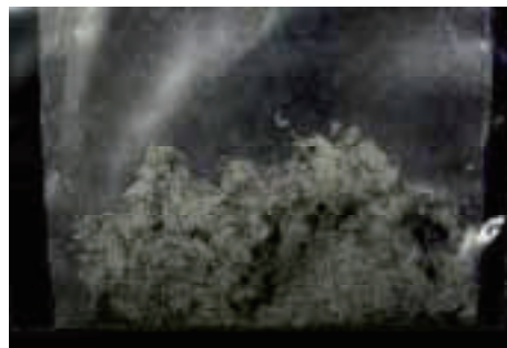
除去されたアスベスト
