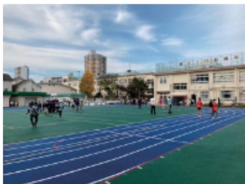
西巣鴨小学校 校庭舗装
