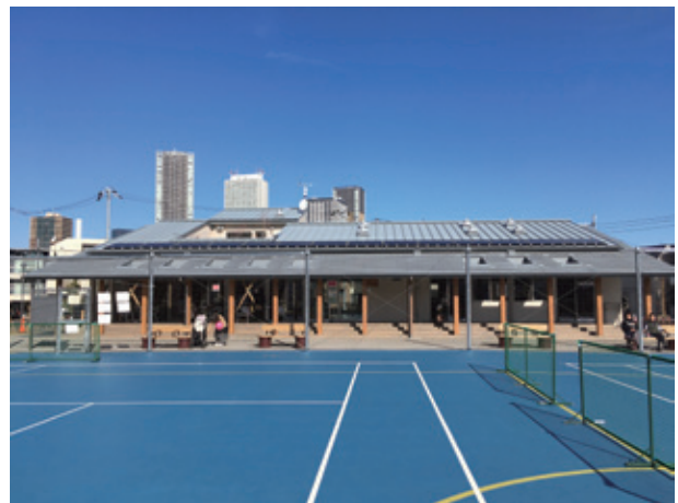
雑司が谷公園丘の上テラス 太陽光パネル
