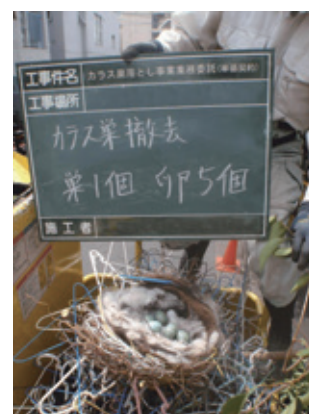
撤去したカラスの巣
