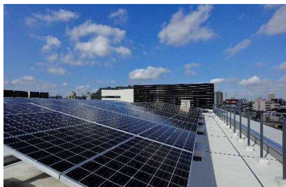
池袋本町小中連携校に設置した太陽光発電システム
