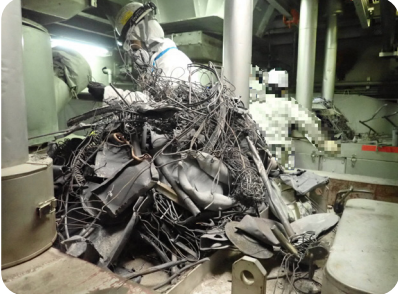
焼却炉から出てきた不燃物
