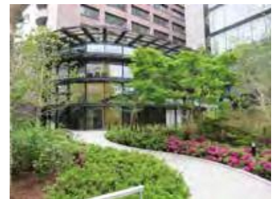
図表138 三井住友海上 ECOM駿河台 (環境コミュニケーションスペース)
