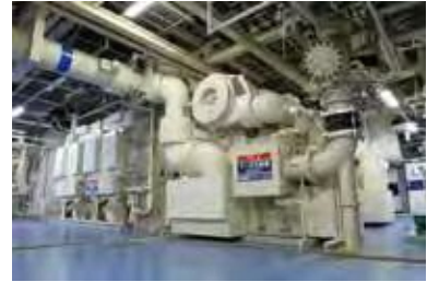
図表233 地域冷暖房施設(ターボ冷凍機)
