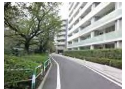
図表259 工場跡地に建つマンション
