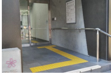
分庁舎出入口
