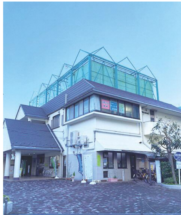
中高生センタージャンプ東池袋 （改修工事前）
