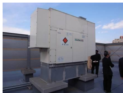
非常用大型発電機
