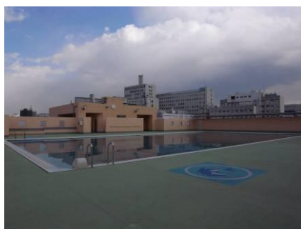
貯水槽を兼ねる屋上プール
