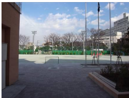
校庭には 100t 雨水貯留槽を設置
