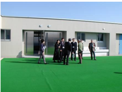
冬季は蓋がけ利用する屋上プール
