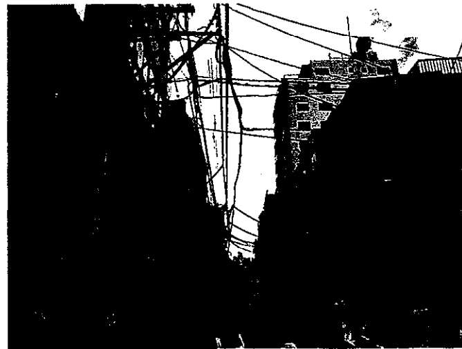
巣鴨地蔵通り電柱の現状
