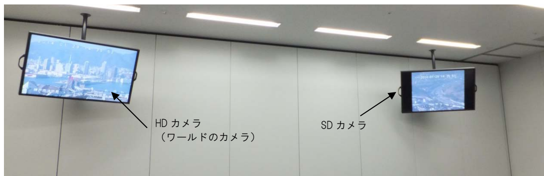
危機管理室に設置されている監視カメラの映像モニター
