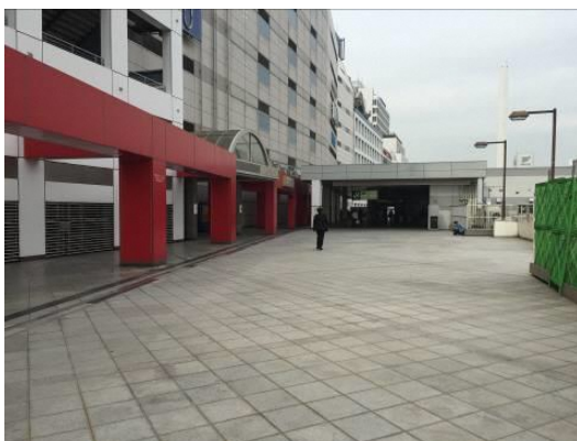
図表10 メトロポリタンビルの既存デッキ
