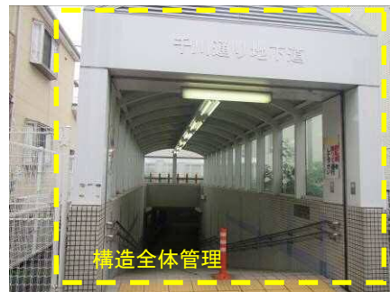
構造全体管理 （ボックスカルバート）
