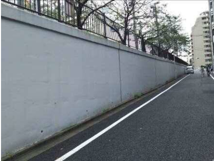
コンクリート擁壁
