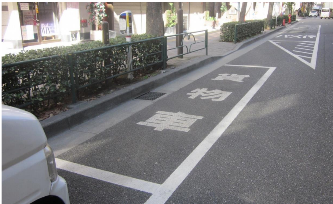
写真 都道 435 号（環状 5 の 1 号）貨物車用パーキング・メーター
