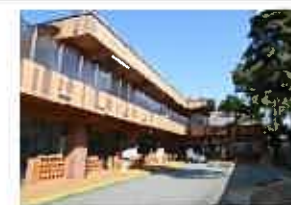
改修工事実施後の園舎の様子
