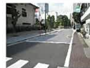
遮熱性舗装施工例(南池袋二丁目)
