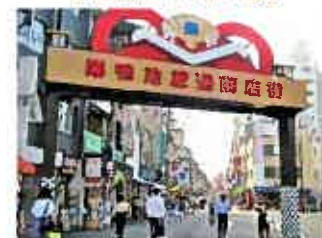
改修したアーチ
