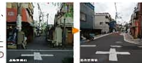
防災生活道路の整備
