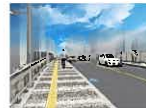
長寿命化修繕計画に基づく西巣鴨橋架替工事
