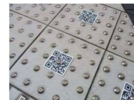
視覚障害者向けの音声ナビゲーションシステム「shikAI」の導入
