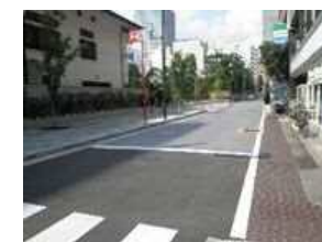
遮熱性舗装施工例(南池袋二丁目)
