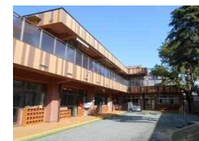
改修工事実施後の園舎の様子
