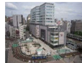
リニューアルした公共空間 大塚駅南口駅前広場
