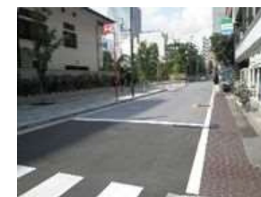
遮熱性舗装施工例(南池袋二丁目)
