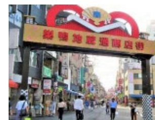
改修したアーチ
