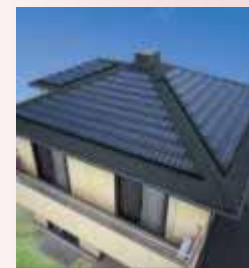
【太陽光パネル】
