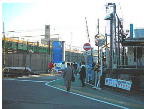
建設中の椎名橋と近接する踏切と駅
