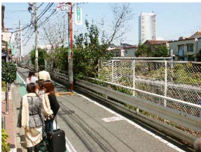
「F.L.ライトの小路」の防護柵、ガードレールを改修
