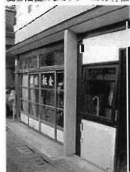
庇と袖壁によるフレームの付加
