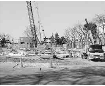
今後の学校施設は(明豊中学校建設現場)
