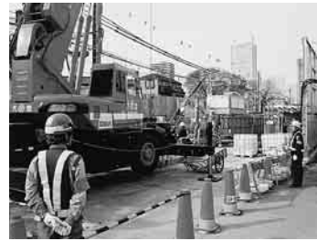
雑司ヶ谷駅(仮称)建設現場
