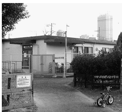
池袋本町防災ひろば内の仮園舎施設
