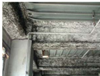
天井などに吹き付けられたアスベスト
