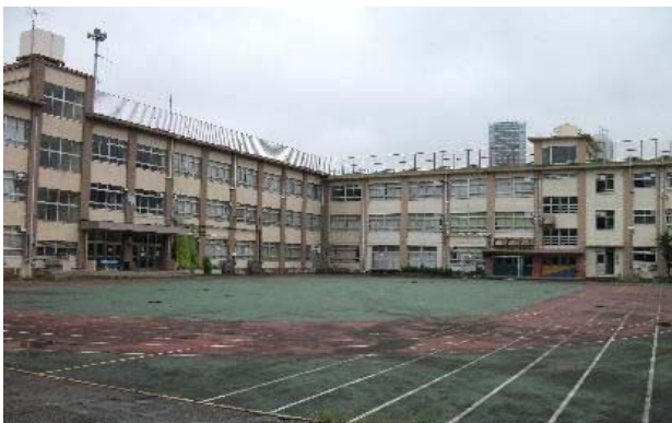
【公園整備が予定されている 旧高田小学校】
