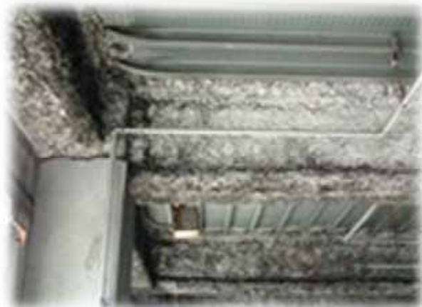
◆天井などに吹き付けられたアスベスト
