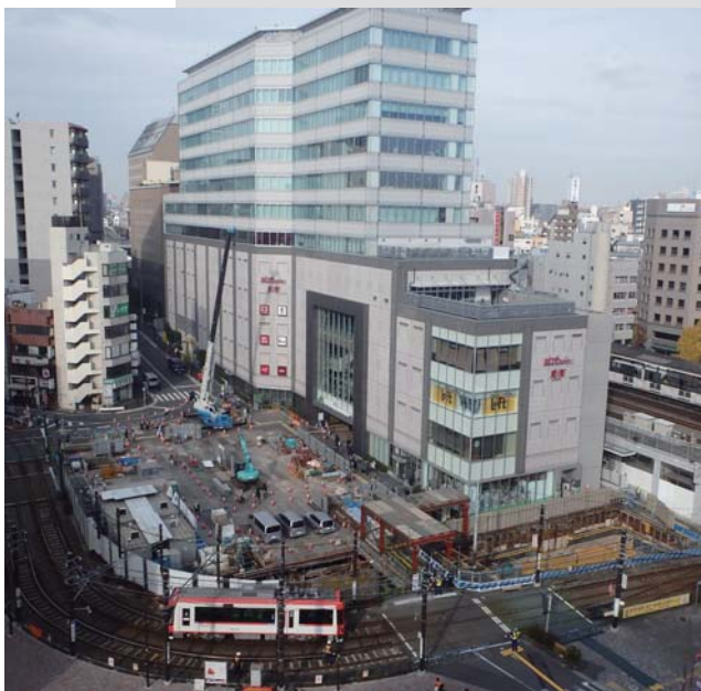
大塚駅南口（自転車駐車場工事の様子）
