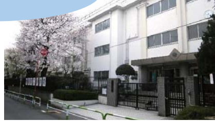
旧池袋第二小学校 昭和 38 年建設 校地面積 8,264 m 2
