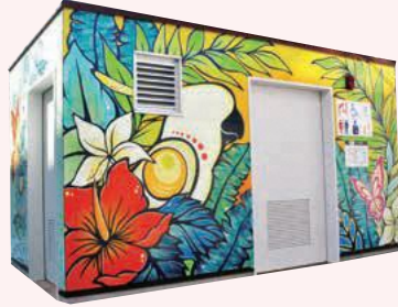
▲アートトイレ第1号 改修するトイレの一部がアートトイレに
