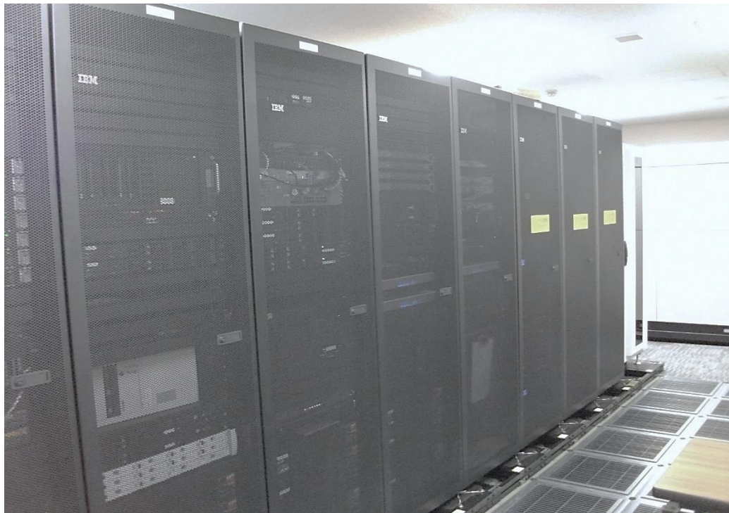
(写真：庁舎サーバー室)
