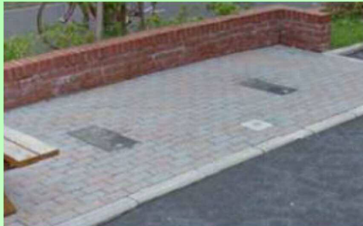
マンホールトイレ (設置例)
