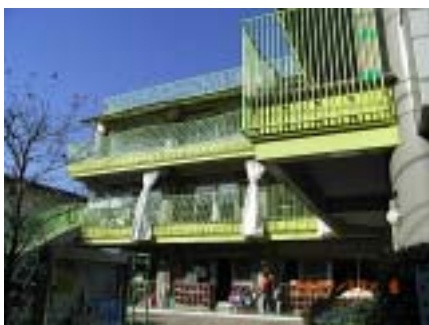
改修工事後の巣鴨第一保育園
