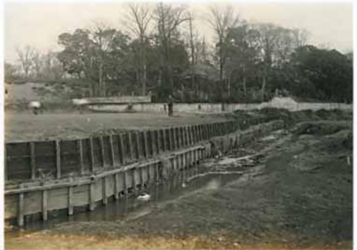
改修前の鶴巻（弦巻）川 下流域の宝城寺と清立院を望む
