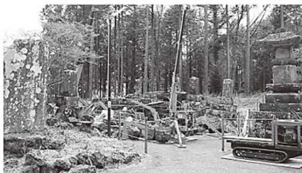
写真2；急ピッチで進められていた、地震で倒れた碑塔類の復旧作業
