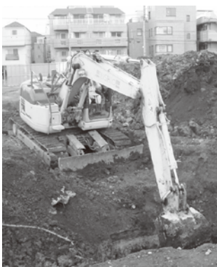
1. 重機による調査区の掘削
