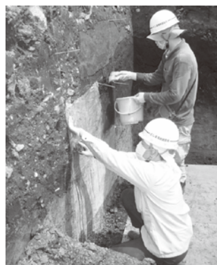
2. 土層へ裏打ち布の貼り付け
