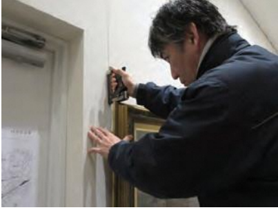
図8 ワイヤーフックの固定
