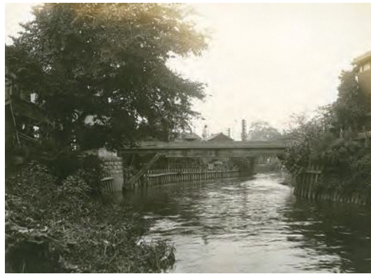
改修前の神田川と面影橋 改修工事は、これより下流に架かる豊橋の上流から着工された。
