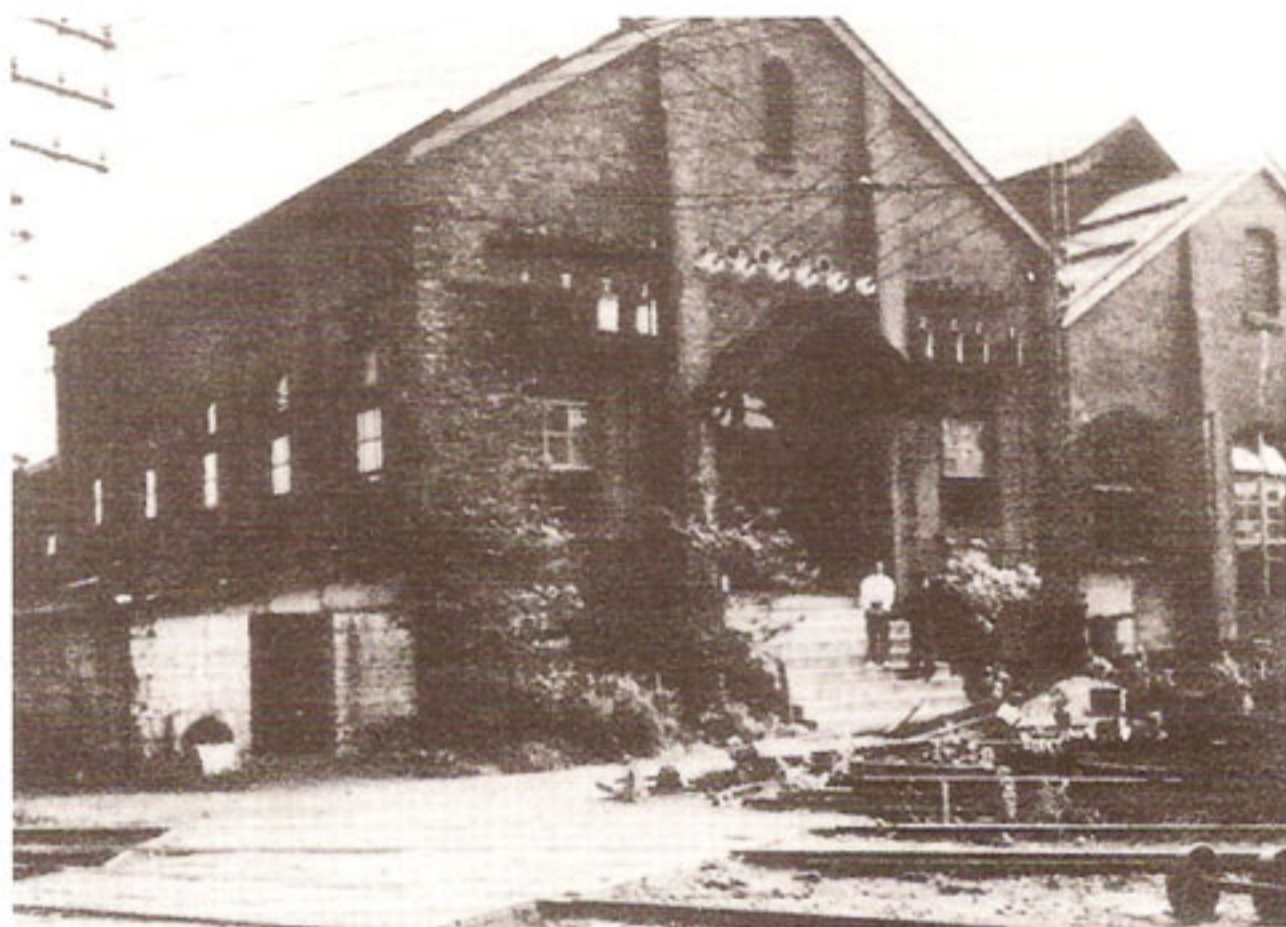
王子電気軌道巢鴨変電所
