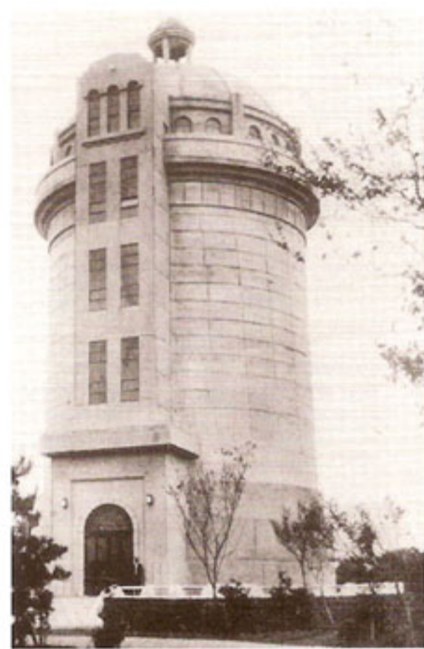
完成直後の大谷口配水塔
