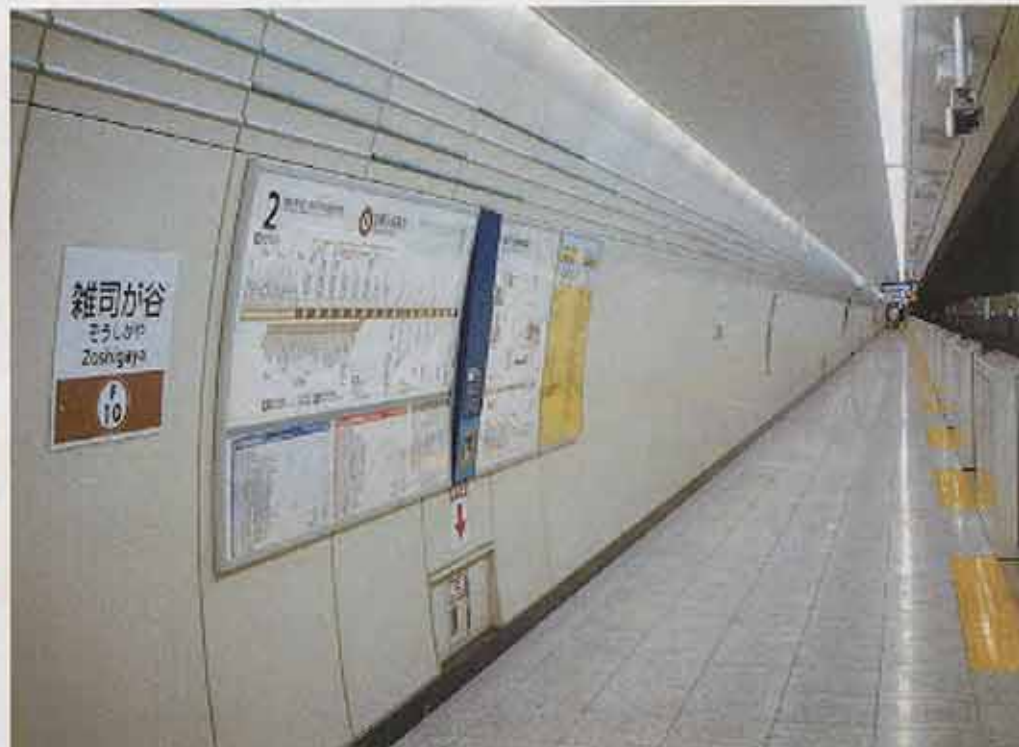
▲転落防護柵が備えられた雑司が谷駅ホーム
