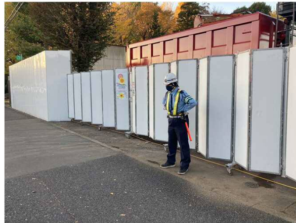
工事用ゲート 交通誘導員
