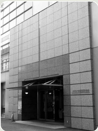
図書館棟正面入口 地上5階、地下2階の建物
