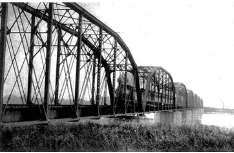
開通後間もない東武鉄道伊勢崎線利根川橋梁 <岩田武氏所蔵>(協力:東武博物館)
